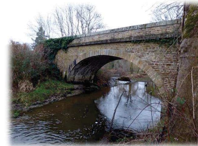
Pont implanté sur le cours de la Semme
