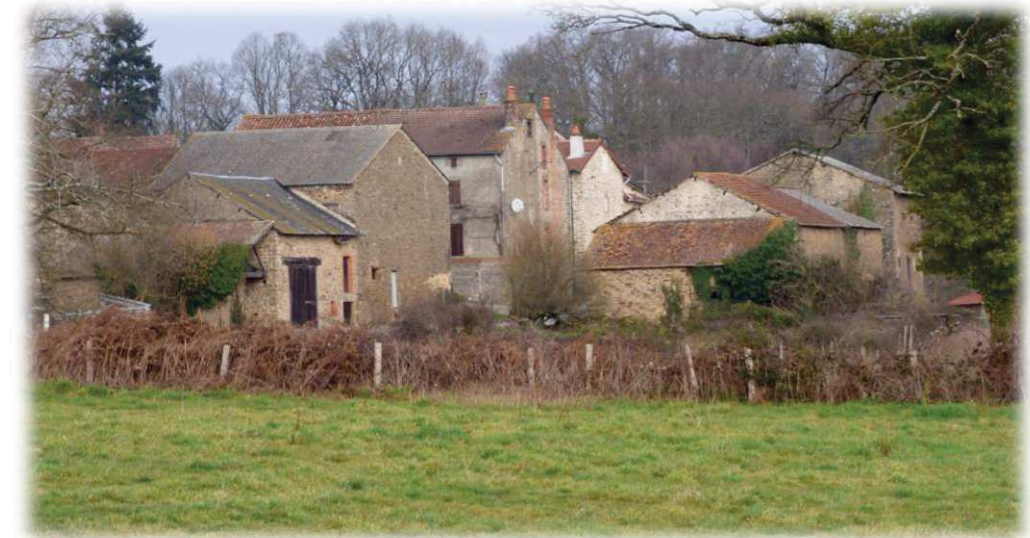
Bâti traditionnel au niveau du hameau de la « Valette Montavie »
