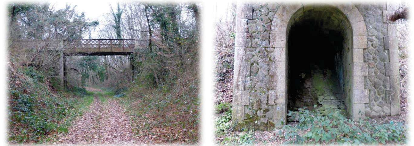
Ouvrages de l'ancienne voie ferrée localisée au Sud de l'AEI
